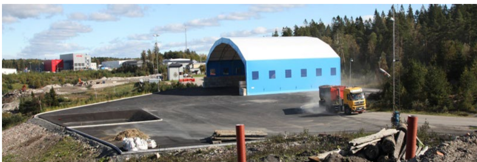
Figur 7. Yta för mellanlagring av avfall med tält för nederbördsskydd.
